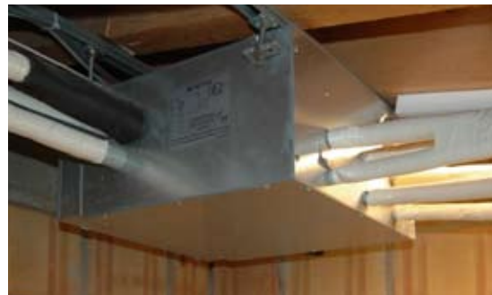
■ Van boven naar onder: Het Multi V Sync II-systeem; LG NeoPLasma binneneunit; centrale regeling AC Smart; rooster van Schako en Eco V, de ventilatiegroep met warmterecuperatie van LG
